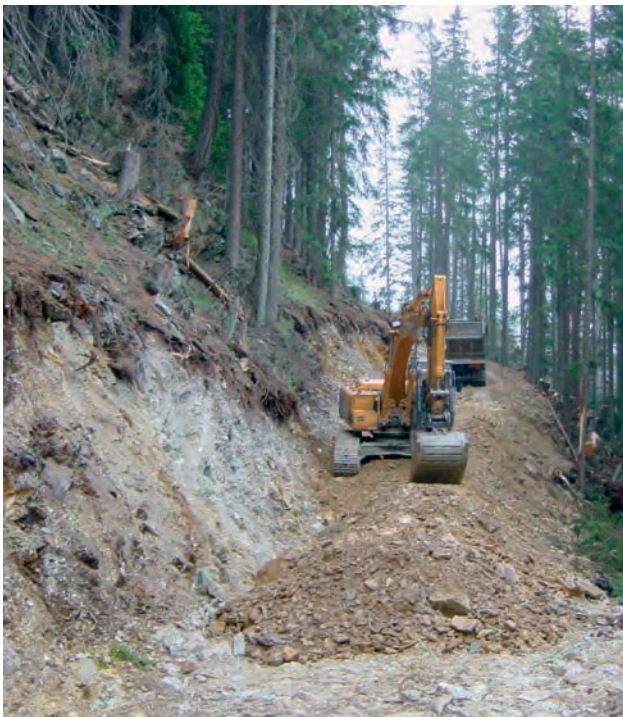
Abbildung 74: Straßenbau im Schutzwald
